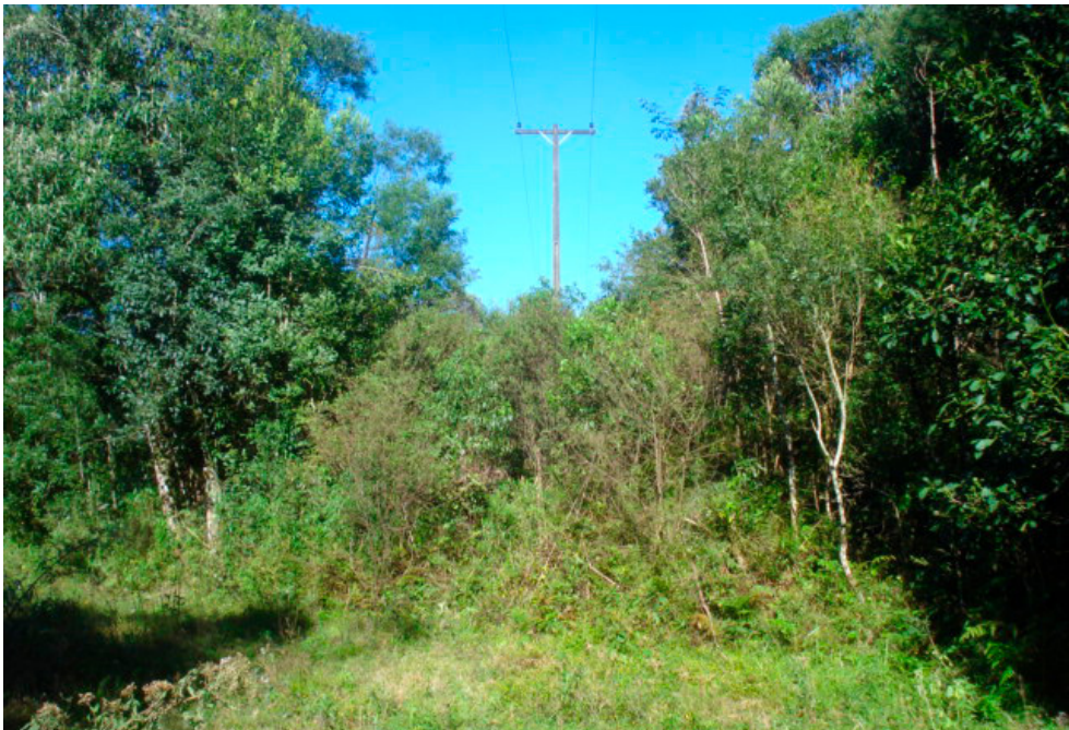
Área com necessidade de controle de vegetação predominantemente nativa em zona rural, em local sem restrições ambientais, onde é aplicada roçada manual.
